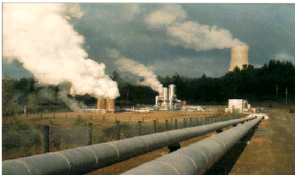
Рис.1 Геотермальная электростанция Охааки-Бродлэндс в Новой Зеландии Установленная мощность 113 мвт. На переднем плане паропроводы, в центральной части: справа сепараторы, слева глушители. На заднем плане - градирня.
