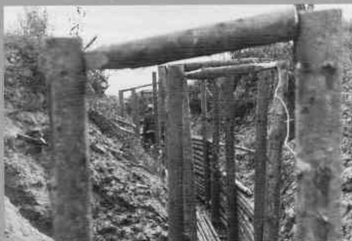
Лето 1942 г. Немецкий bunker в лесу. Несколько рядов бревен с засыпанными землей промежутками. Волховский фронт. Фото X. Вилерса
