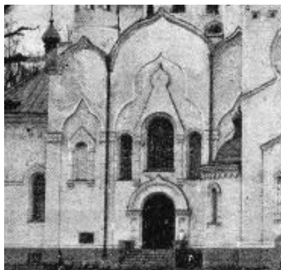
Фрагмент северного фасада Покровского храма на Громовском кладбище.
