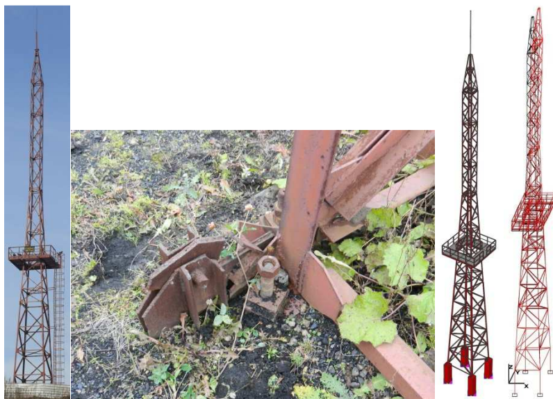
Рис. 1. Общий вид вышки молниеотвода (слева), дефекты в соединениях элементов (в центре) и расчетная и деформированная схема (справа)
