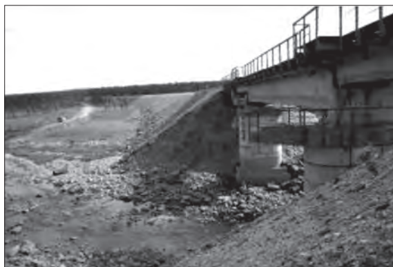
Рис. 2. Сплыв откоса насыпи в результате размыва ее основания в паводок у мостового перехода. Верховье ручья Васильевский (171 км).
