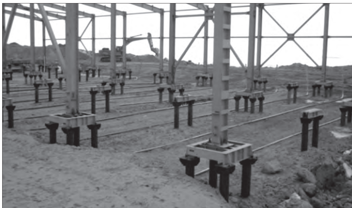
Рис. 4. Засыпка грунтом смонтированных ДОУ-1 модификации 03 при строительстве здания с полами по грунту на Бованенковском НГКМ.
