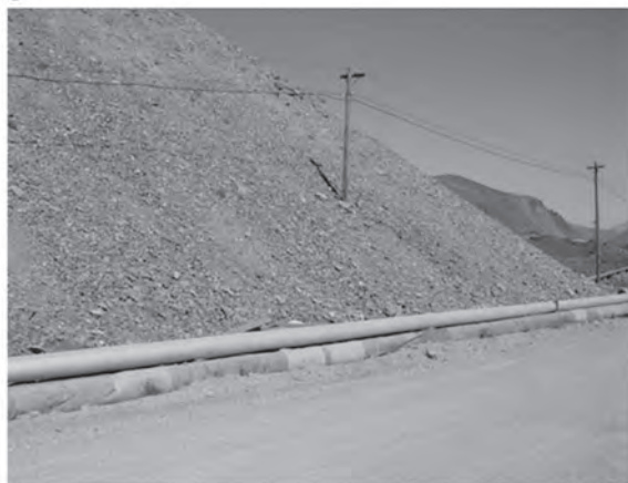
Рис. 1. Каменные глетчеры в окрестностях поселка Провидения. Чукотский полуостров. а - активный каровый каменный глетчер, нависающий над нефтехранилищем; б - линия электропередач и водовод на фронтальном откосе активного присклонового каменного глетчера.
