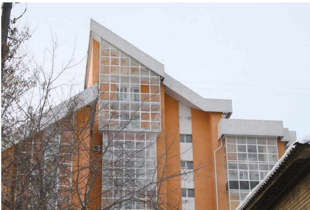
Рис. 23. Островерхие крыши на ул. Александра Невского
