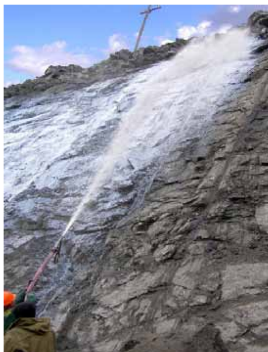
Рис. 8. Покрытие откосов карьера биорикулатом.
