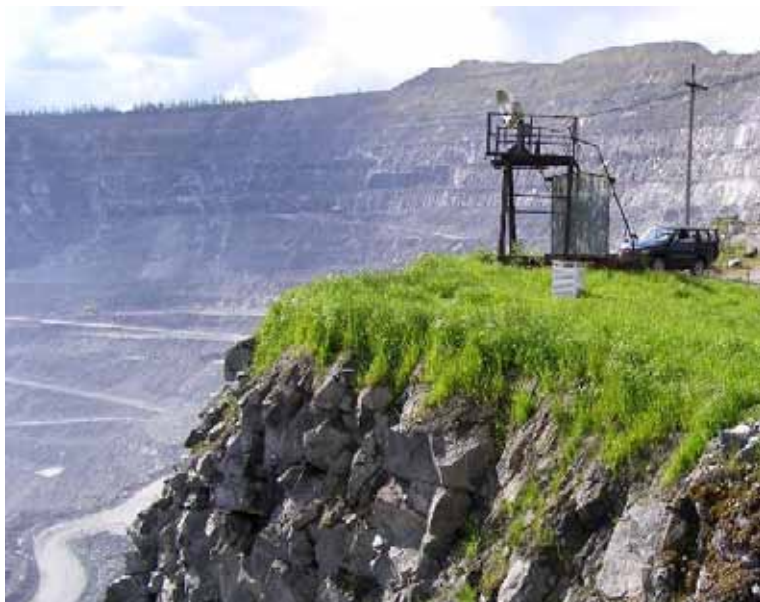
Рис. 9. Травяные покрытия на хвостохранилищах Ковдора.
