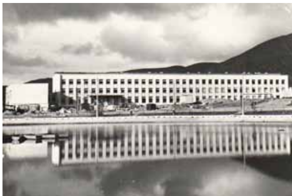
Рис. 2. Строится новое здание вечернего факультета. 1974 г.
