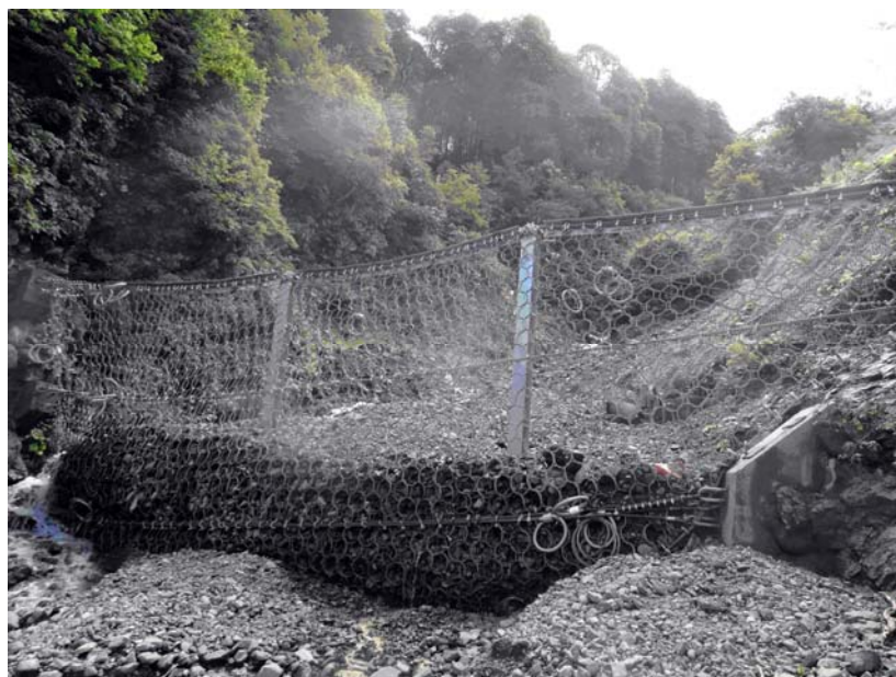
Рис. 2. Первый в современной истории России гибкий противоселевой барьер производства Geobrugg AG, удержавший селевую массу
