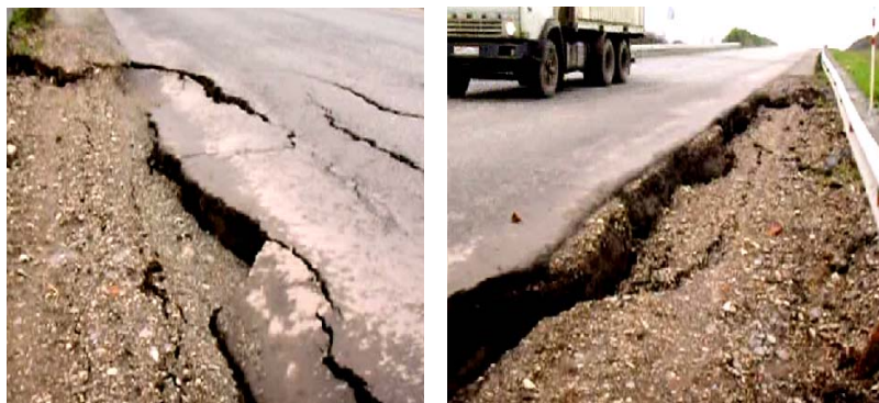
Рис. 1. Оползневые деформации на автомобильной дороге А-151 на участке подхода к мостовому переходу через р. Кошелейка. Южная ( а ) и северная ( б ) границы оползня (Комсомольский район, 2007 г.)
