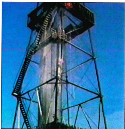
Рис. 1.1. Аварийное фонтанирование предельно насыщенных хлоридных магниево-кальциевых рассолов. Иркутская область, Ковыктинская нефтегазоразведочная площадь, скважина №18 (фото А. Г. Вахромеева, 27.01.1994 г.).
