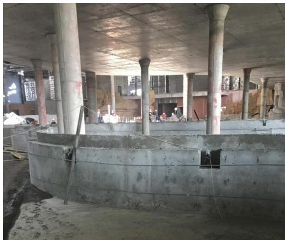
Строительство аквапарка «ЛетоЛето»
