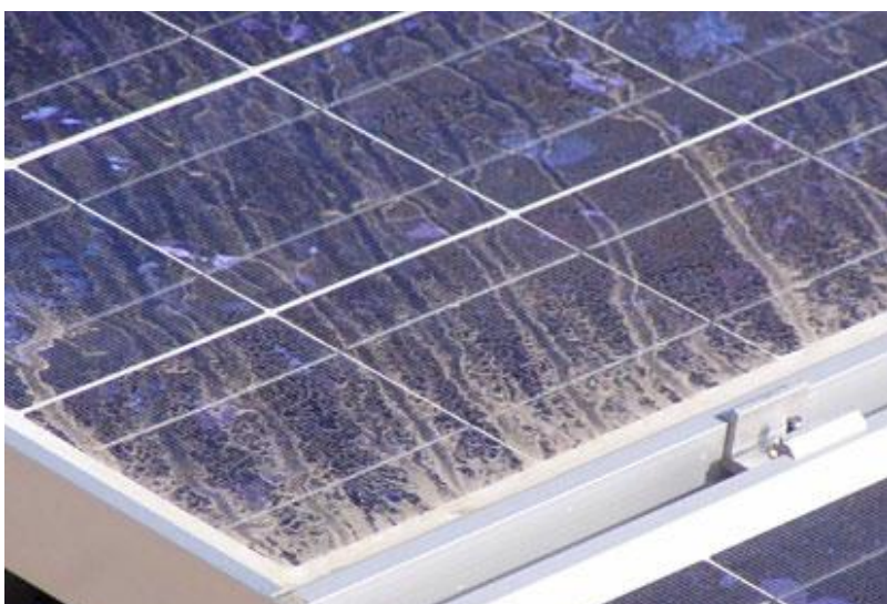
Рис. 3 – Накопление грязи в углах солнечной панели [7] Fig. 3 – Accumulation of dirt in the corners of the solar panel [7]
