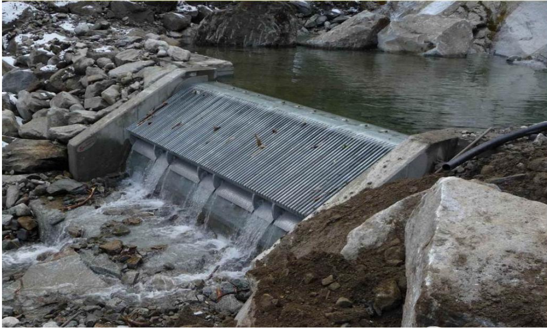
Рис. 3 – Водозабор высоконапорной малой ГЭС «Шипот-2» Fig. 3 – Water intake of high-head small HPP “Shypot-2”
