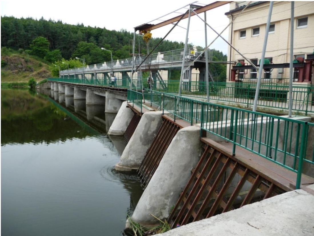
Рис. 1 – Низконапорная Сабаровская малая ГЭС Fig. 1 – Sabarovskaya low-head small HPP
