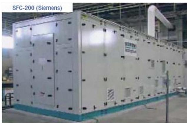
**Рис. 9** – ГЭУ фирмы Siemens с газовой турбиной фирмы Ingersoll-Rand Energy Systems [22]
