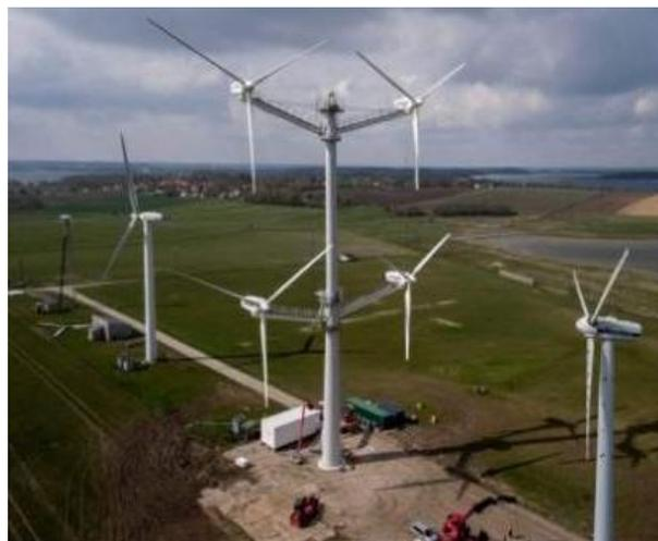
Рис. 2 – Ветроэнергетическая установка Vestas с 12 лопастями
