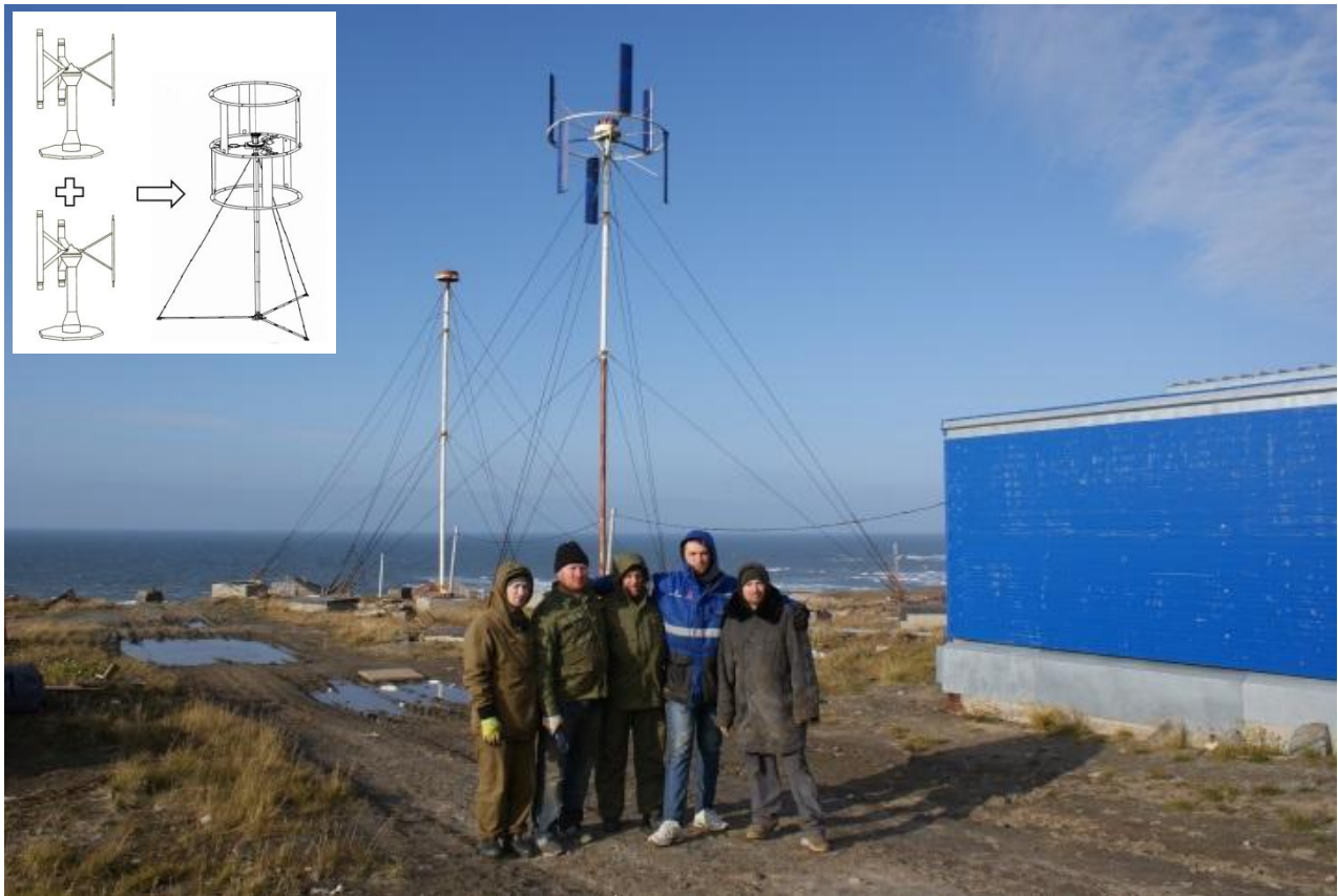
Рис. 4 – Вертикально-осевая ветроэнергетическая установка ВЭУ-3(6) в Арктике, мыс Канин нос: несколько ярусов на одной мачте увеличивают единичную мощность (вверху слева) Fig. 4 – WPU-3(6) Vertical Axis Wind Turbine in Arctic, Kanin Nos Cape: several tiers on the same mast increase the unit power (upper left)
