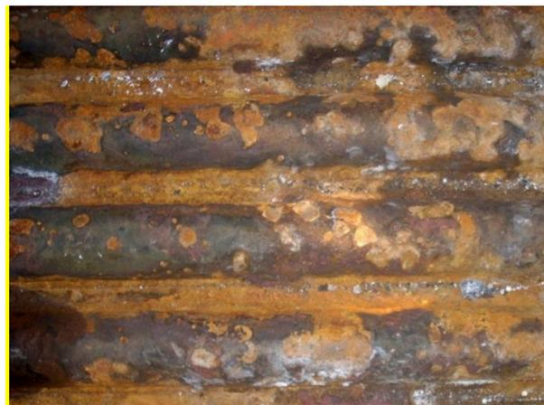
**Рис. 3** – Язвенная коррозия экранных труб
