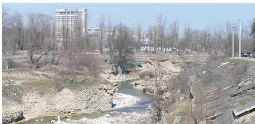
**Рис. 3. Результаты воздействия паводковых вод на состояние поймы и берегозащитных сооружений р. Нальчик**
