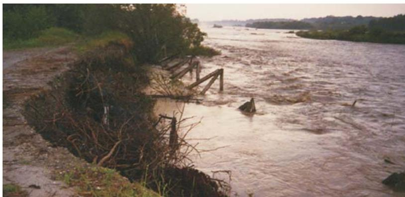
**Рис. 2 . Тетраэдрсы, разрушенные на р. Терек**
