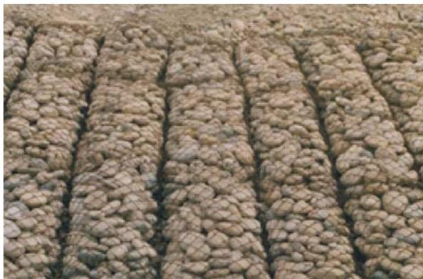
Рис. 5. Технология укладки и общий вид откосного крепления из полумонолитных габионов
