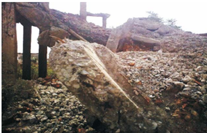
Рис. 1. Строительные отходы разборки зданий и сооружений в виде железобетонного лома
