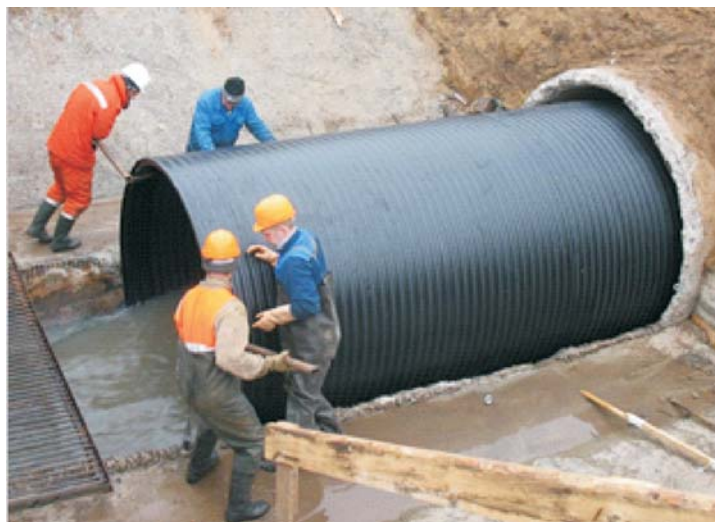
Рис. 6. Реконструкция канализационного коллектора
