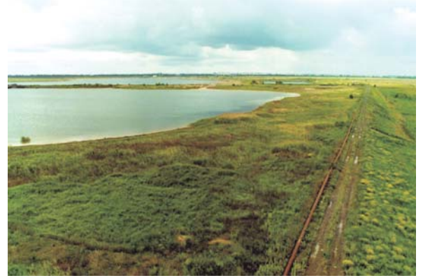
Рис. 1. Общий вид действующего хвостохранилища в балке "Щ" по складированию продуктов гидрометаллургической переработки руд
