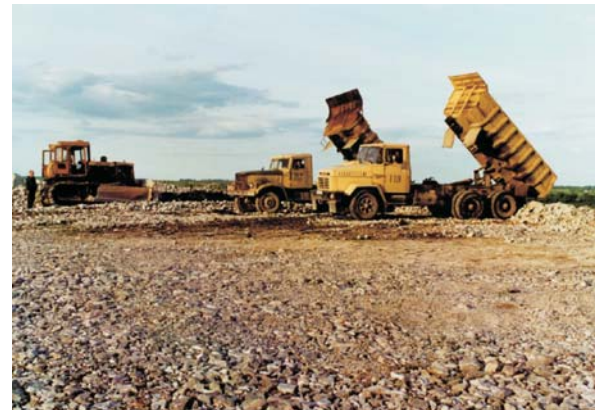
Рис. 2. Горно-техническая рекультивация на хвостохранилище "КБЖ" (фото)
