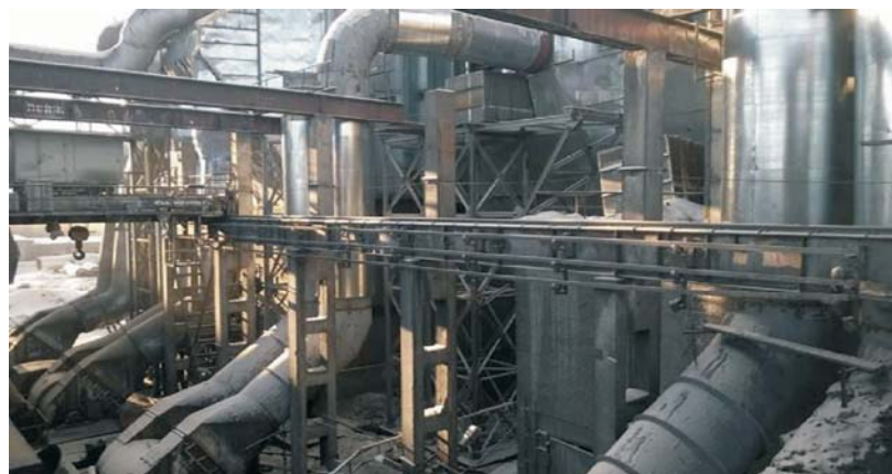
Рис. 2. Перевод газов от печи спекания № 1 на карбонизацию Fig. 2. Transfer of gases from sintering furnace No. 1 to carbonization
