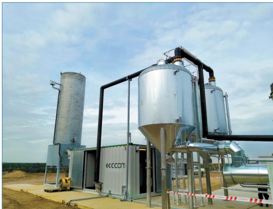
Рис. 7. Система осушки и очистки биогаза
