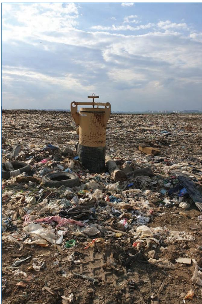
Рис. 5. Нарастающая газовая скважина на рабочей карте полигона
