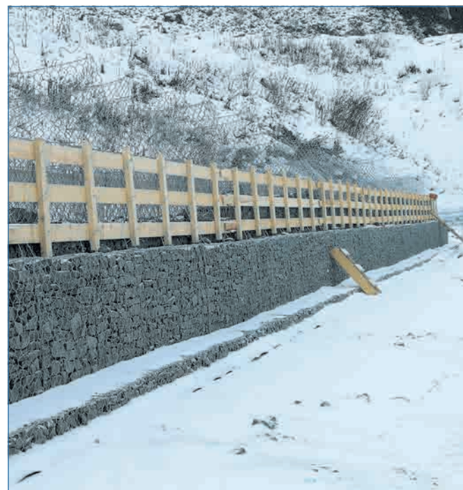
Фото 2. Габрионная стена по контуру в основании полигона
