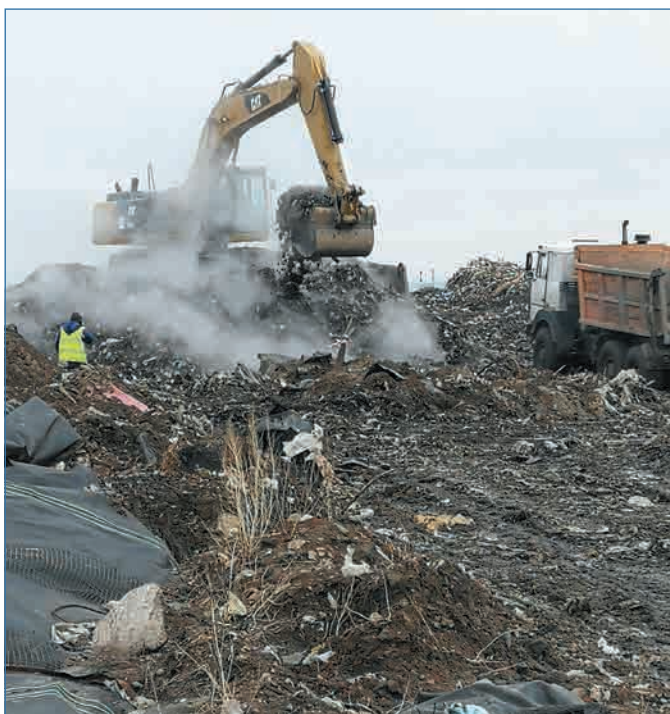
Фото 1. Работы по формированию откосов
