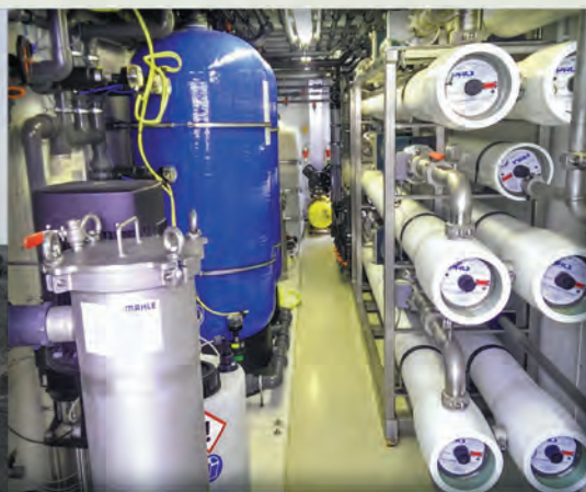
Очистные сооружения для очистки фильтрата полигона ТКО
