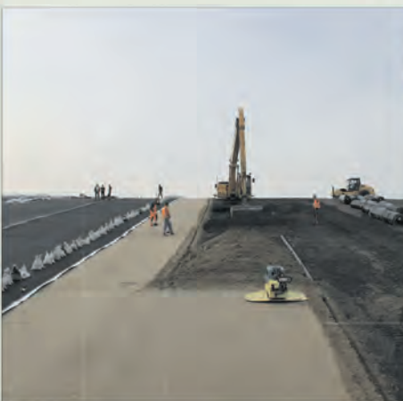
Строительство полигона ТКО
