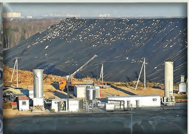
Система сбора, очистки и обезвреживания свалочного газа
