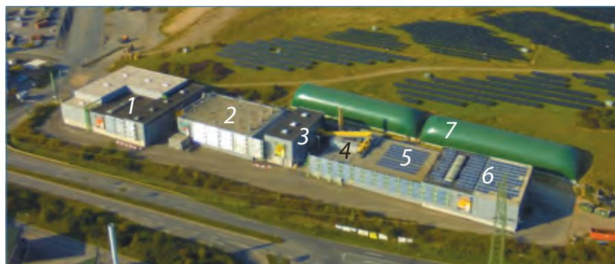
Рис. 1. Биогазовая установка: 1 – цех приемки и подготовки, 2 – установка сбраживания, 3 – цех отжима и емкость для хранения отделенной воды, 4 – вытяжная установка, 5 – установка для перемешивания, 6 – цех обработки биошлама, 7 – резервуар для биогаза
