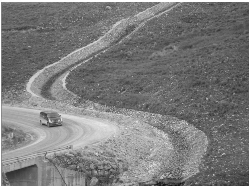
Рис. 3. Водоотводная канава
