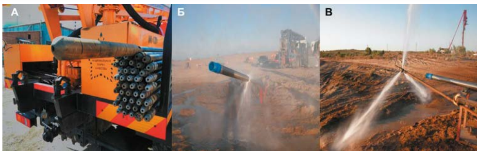
Рис. 1. Гидроерш для промывки фильтров: А — гидроерш с комплектом бурильных труб на платформе буровой установки УРБ — 2ДЗ; Б — вращающийся промывочный узел (Джеттинг) в фильтре Джонсон скрин; В — вращающийся промывочный узел (Джеттинг) на поверхности
