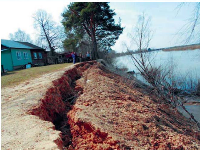
Рис. 2. Оползневой участок, с. Сандогора
