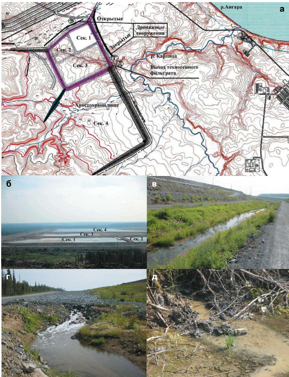
Рис. 1. Хвостохранилище Новоангарского обогатительного комбината: а — рельеф и гидрография площадки строительства хвостохранилища; б — общий вид эксплуатируемого хвостохранилища; в — открытый дренажный канал; г — закрытый дренажный канал; д — выход техногенного фильтрата из хвостохранилища в правый приток р. Картица. Сек. — 1, 2, 3, 4 — обозначение рабочих секций и их номера
