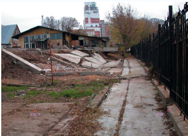
Рис. 4. Стенка срыва оползневой субблока и самая широкая часть сползшей прибровочной части на территории Храма Живоначальной Троицы (12.10.06 г.) [5], оползневой участок Хорошево-1
