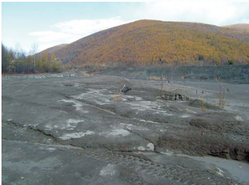
Рис. 1. Разлив сточных осадков хвостохранилища в результате прорыва ограждающей дамбы
