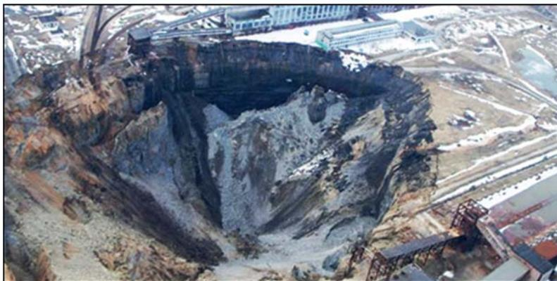
**Рис. 1. Провал на Березниковском калийном производственном рудоуправлении № 1 [7]**
