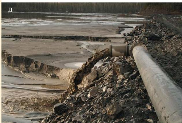
**Рис. 1.** Хвостохранилище Советской ЗИФ: а — схема строения хвостохранилища; б — общий вид секции № 1; в — общий вид секции № 2; г — опорная дамба (1) и насосная станция осветленных вод (2); д — сброс пульпы в районе разделительной дамбы в секцию № 1
