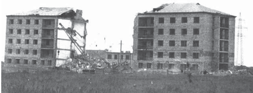
Рис. 1. Здание, разрушившееся вследствие подтопления в процессе строительства (фото автора)
