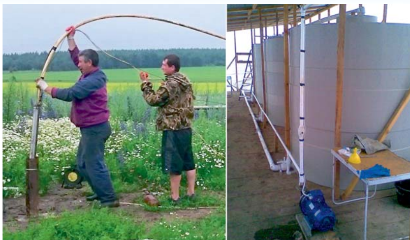
Рис. 6. Сооружение подземного и наземного комплекса по скважинному подземному выщелачиванию
