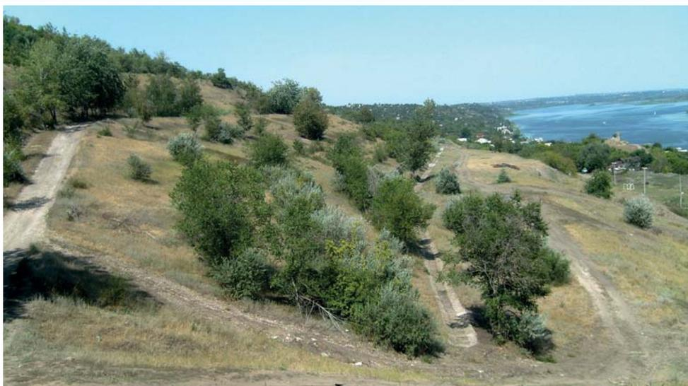
**Рис. 4. Противооползневые террасы в центральной части Затонского оползня**
