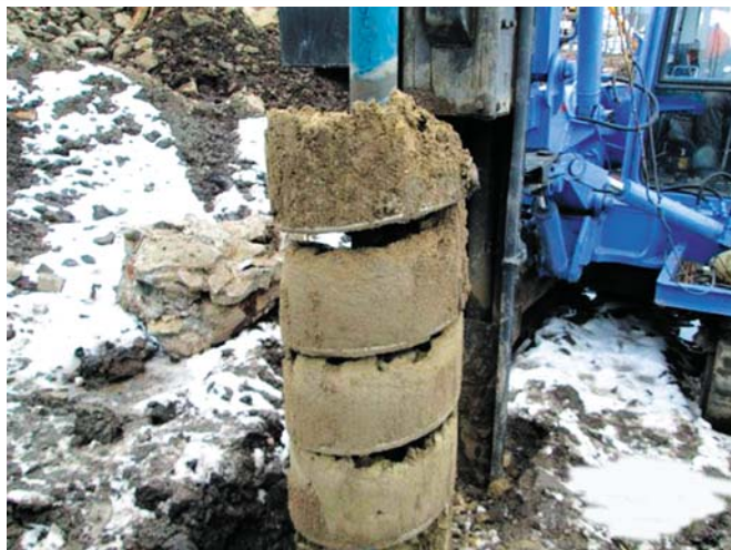
Рис. 2. Шнековое бурение скважин
