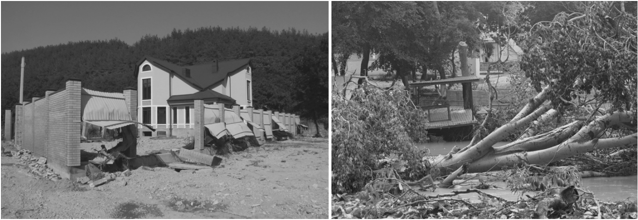
Рис. 4. Следы прохождения паводка 06.07.2012 г. в долине р. Ашамба.
