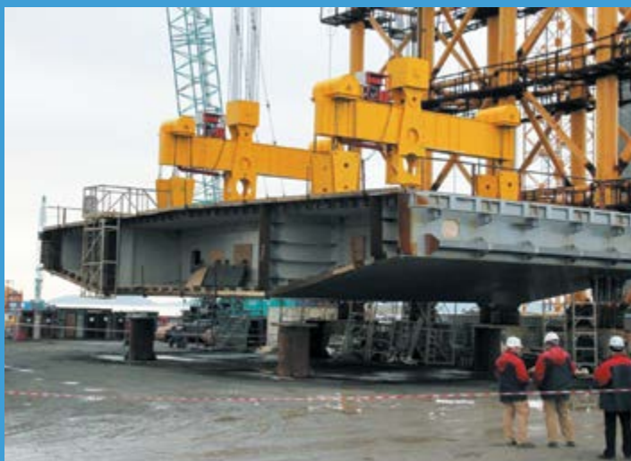
Монтаж руслового пролетного строения
