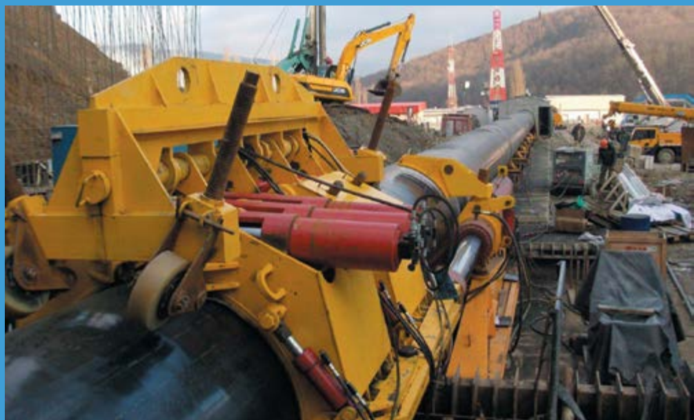
Установка проталкивания трубопровода в тоннельный переход
