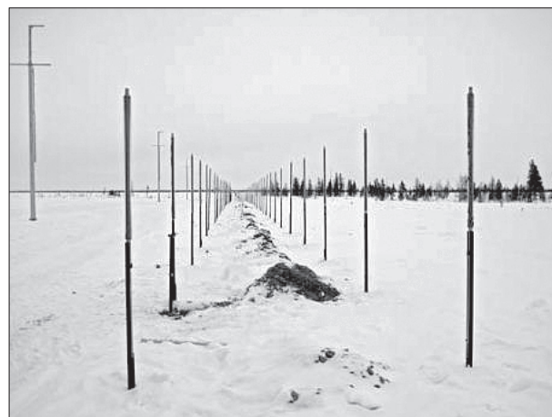
Рис. 4. Подземная прокладка нефтепровода Ванкор–Пурпе с охлаждающим контуром из термосифонов.
