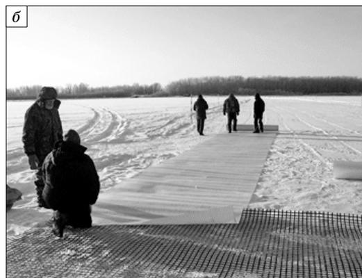
Рис. 11. Укладка георешетки на стыке ледовой плиты с берегом (а) и стыковка стеклосетки и георешетки (б).
