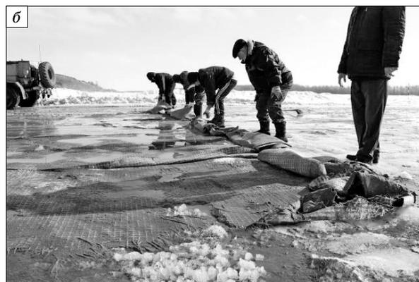
Рис. 16. Удаление геосинтетических материалов:
