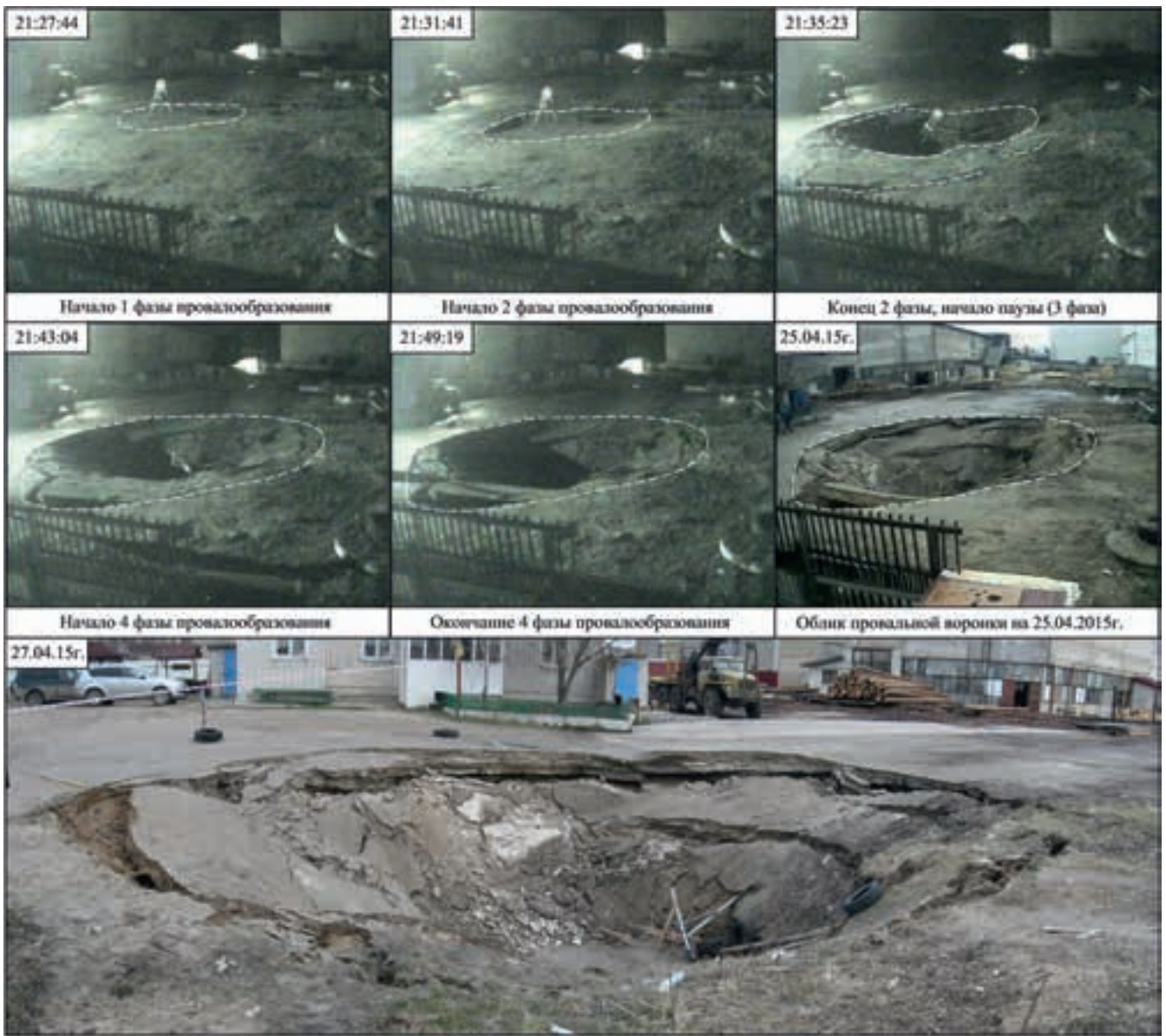
Рис. 12. Фазы образования карстового провала (г. Дзержинск)
