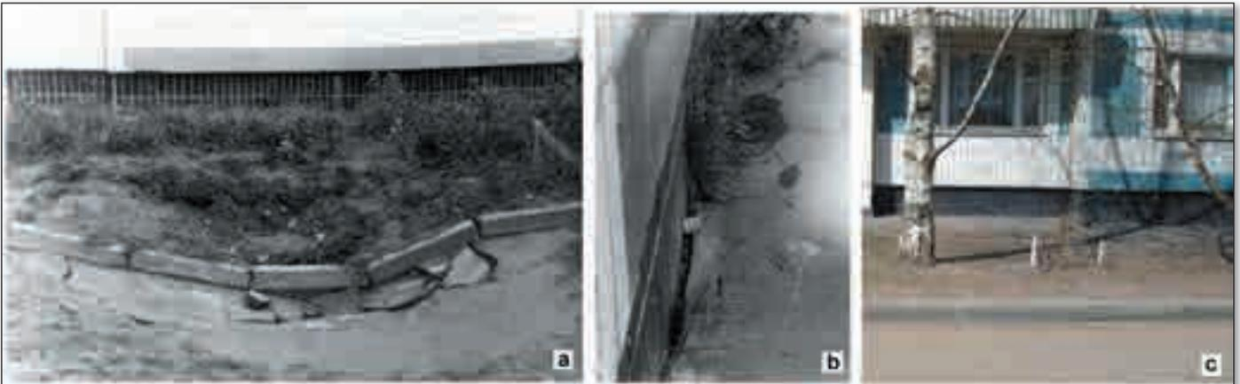
**Рис. 2.** Центральная провальная (потому что обрушилось асфальтовое покрытие) часть воронки оседания (а) (8, табл. 1) и неравномерное деформирование отмостки (b) у фасада дома 17/1 по ул. Маршала Тухачевского (4 июня 1987 г.); фасад дома и центральная часть бывшей воронки спустя 22 года (с): заметны незначительные деформации газона у фасада дома вследствие уплотнения грунтов (28 апреля 2009 г.)
