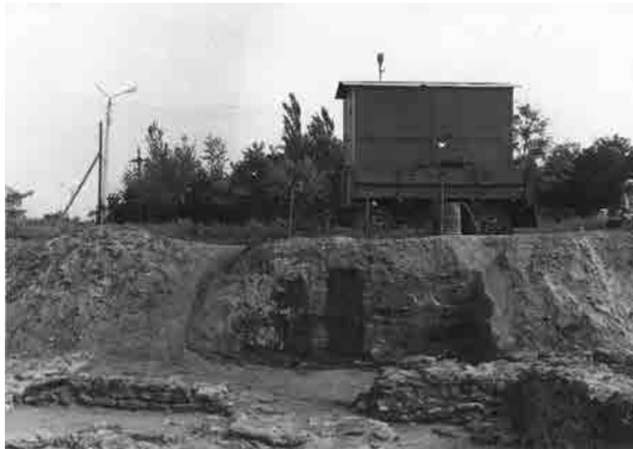
Рис. 5. Инъектирование грунтов культурного слоя, слагающих борт археологического раскопа городища Танаис
