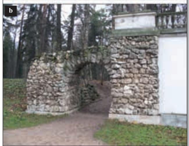
**Рис. 6. Полуарки арбутанов для смягчения температурных воздействий на нижнюю подпорную стенку в Архангельском: а — полуарка восточного арбутана; б — полуарка западного арбутана (фото М.М. Михайлова)**
