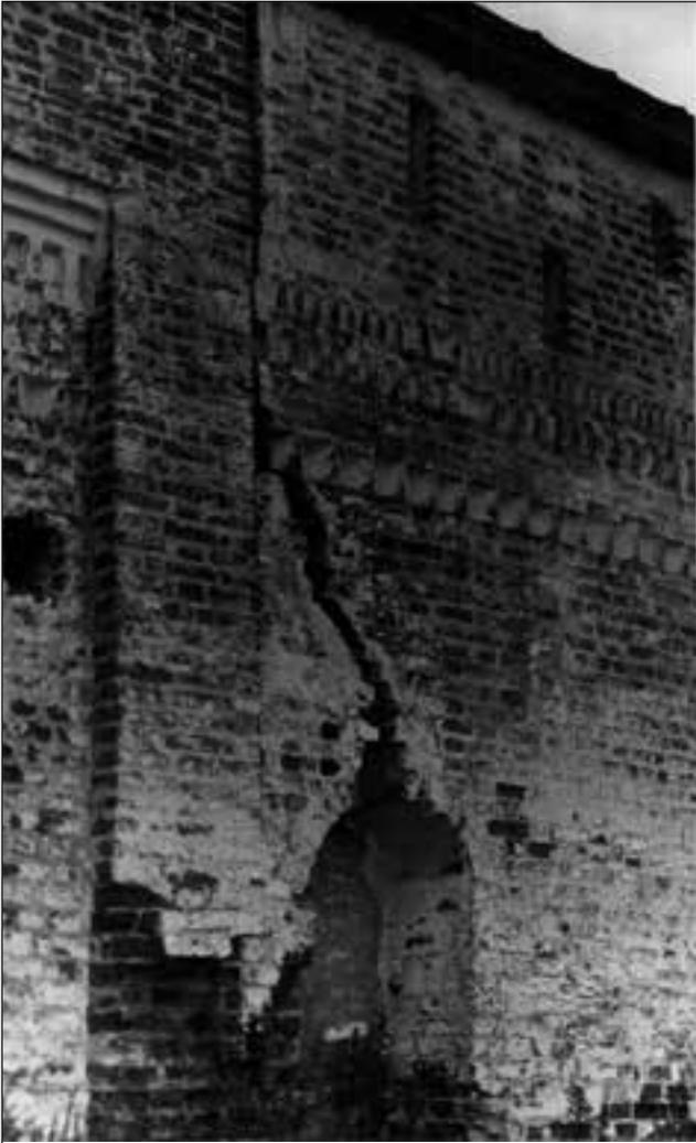
**Рис. 3. Трещина отрыва на месте примыкания прясла к Кузнечной башне Кирилло-Белозерского монастыря**
