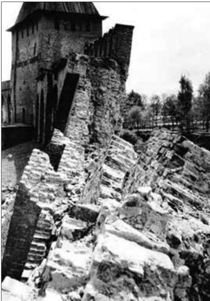
**Рис. 11.** Продольная трещина в торце сохранившегося прясла после его падения в 1991 г.
