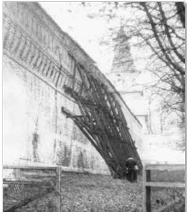
**Рис. 7. Устройство деревянного арбутана для предотвращения падения прясла вблизи Елизаветинской башни**
