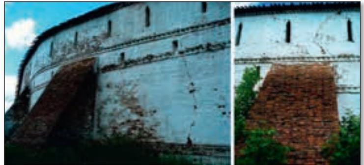
**Рис. 9.** Характер развития температурных деформаций на участках прясел значительной кривизны
