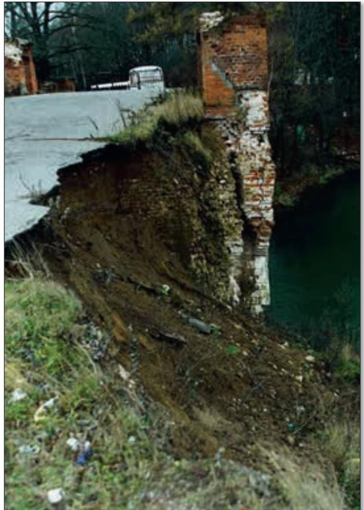
**Рис. 10.** Продольная трещина в сохранившейся части подпорной стены моста в Марфино
