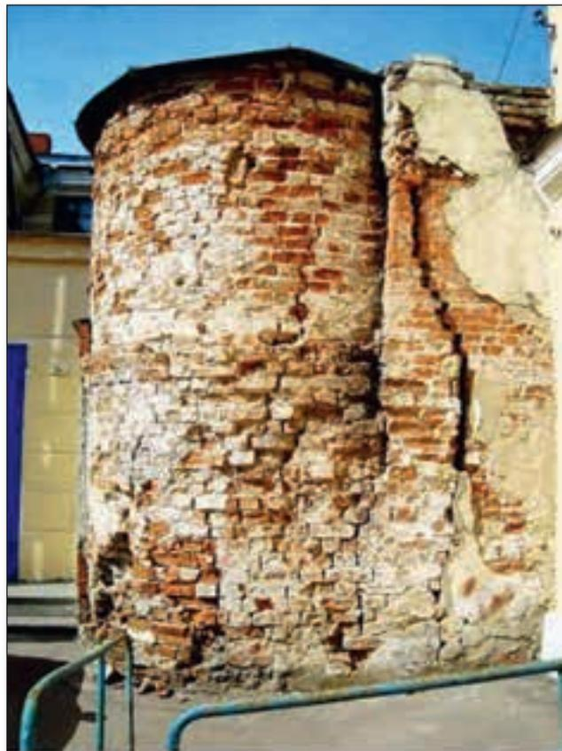
**Рис. 12.** Деформация прясла и юго-восточной башни Рождественского монастыря при температурном воздействии
