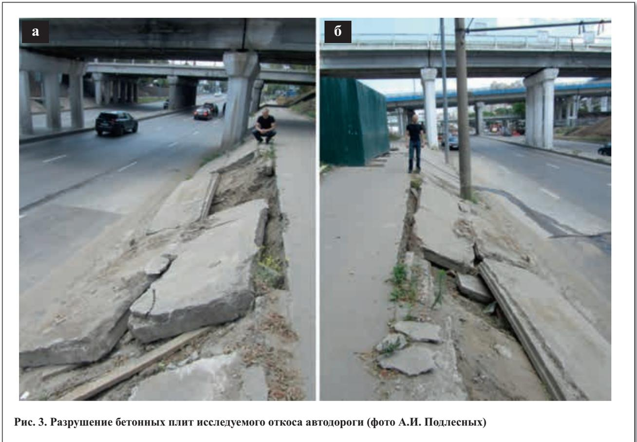
Рис. 3. Разрушение бетонных плит исследуемого откоса автодороги (фото А.И. Подлесных)
