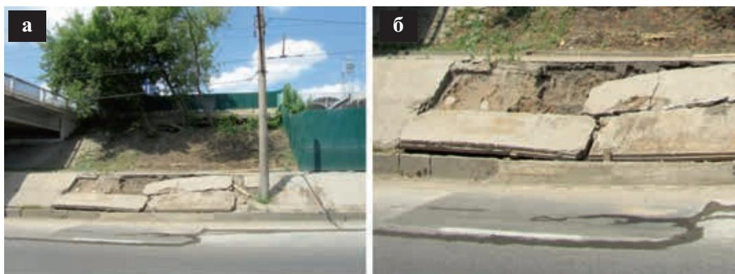
Рис. 6. Разрушенные плиты облицовки откоса, восстановленная лента ростверка и асфальтовая латка на проезжей части (фото А.И. Подлесных)
