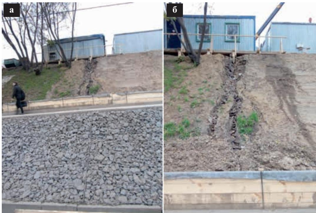
Рис. 7. Откос, укрепленный габионами (а), и эрозионная промоина на поверхности склона (б) (фото И.А. Лаврусевича)
