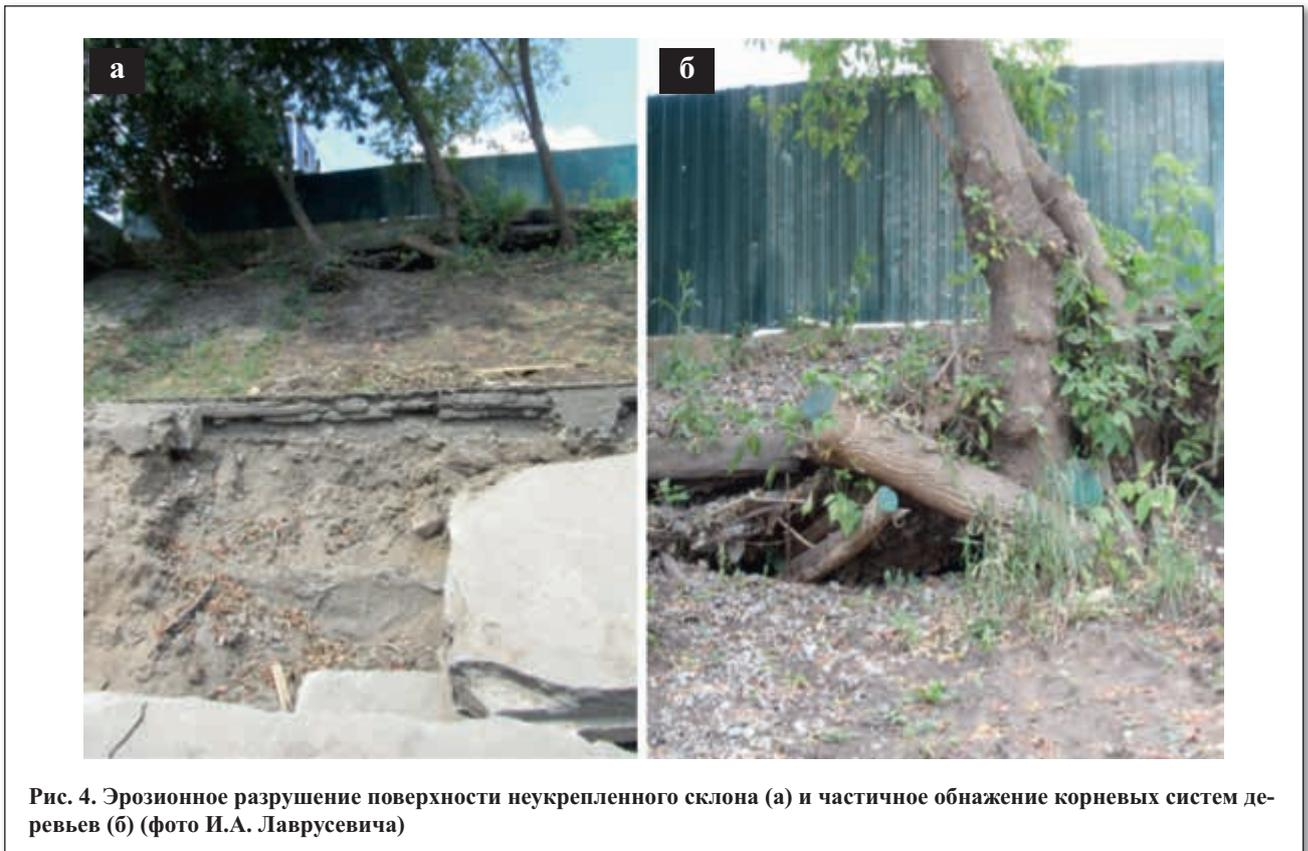
Рис. 4. Эрозионное разрушение поверхности неукрепленного склона (а) и частичное обнажение корневых систем деревьев (б) (фото И.А. Лаврусевича)
