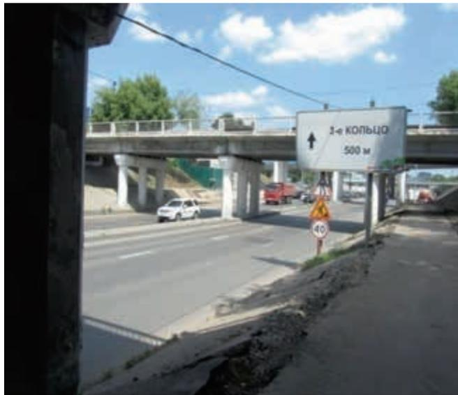
Рис. 2. Место развития суффозионных и эрозионных процессов на откосе автодороги вблизи строения 6 дома 39а на Шмитовском проезде в г. Москве (фото И.А. Лавруевича)
