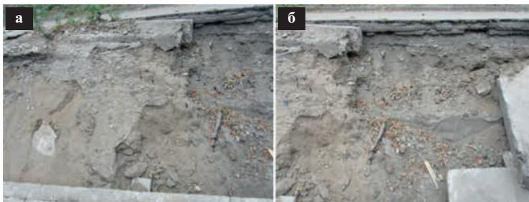
Рис. 5. Разрушенное суффозией основание откоса, сложенное крупно- и среднезернистым песком (фото А.И. Подлесных)
