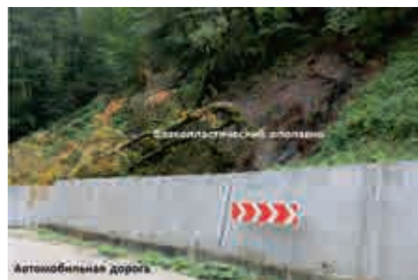
Рис. 3. Автомобильная дорога в выемке, пересекающая языковую часть вязкопластического оползня (ЛТС типа II-A)
