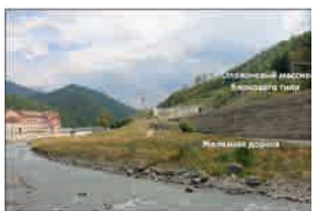
Рис. 5. Железная дорога Адлер — Красная Поляна на насыпи, расположенная в языковой части блокового оползня (ЛТС типа I-Ж)
