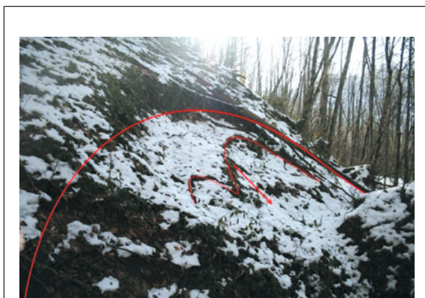
Рис. 7. Мелкий оползень на левом борту безымянного притока р. Ачипсе. Красная линия оконтуривает оползневое тело, красная стрелка показывает направление смещения оползня
