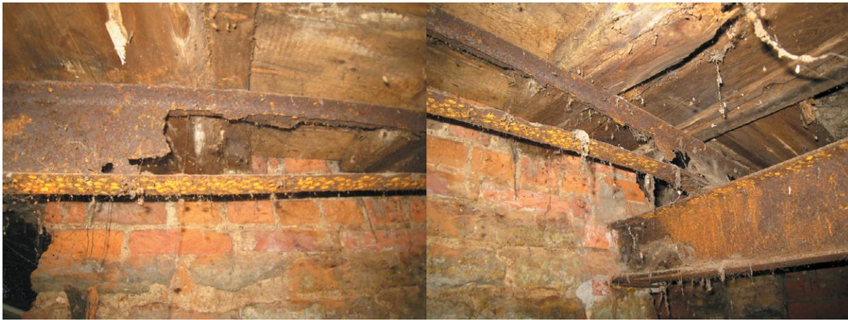
Рис. 2. Поражение древесины в подвальном помещении (образование бурой гнили)
