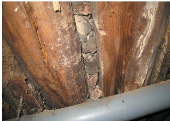
Рис. 3. Коррозия материалов и конструкций в подвальном помещении. Видно сквозное разрушение металлических элементов
