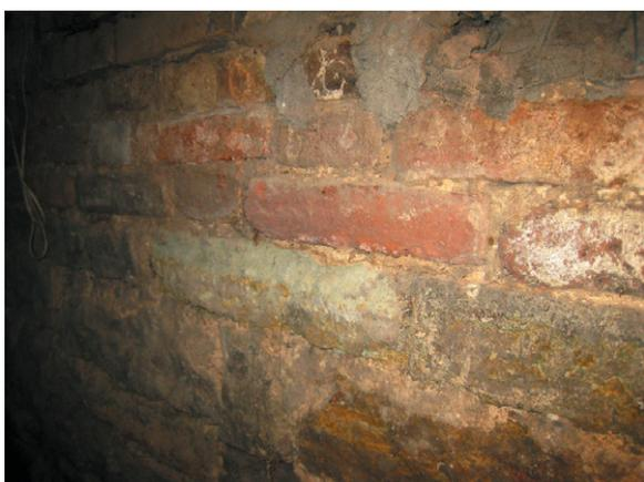
Рис. 4. Повреждение кирпичной кладки
