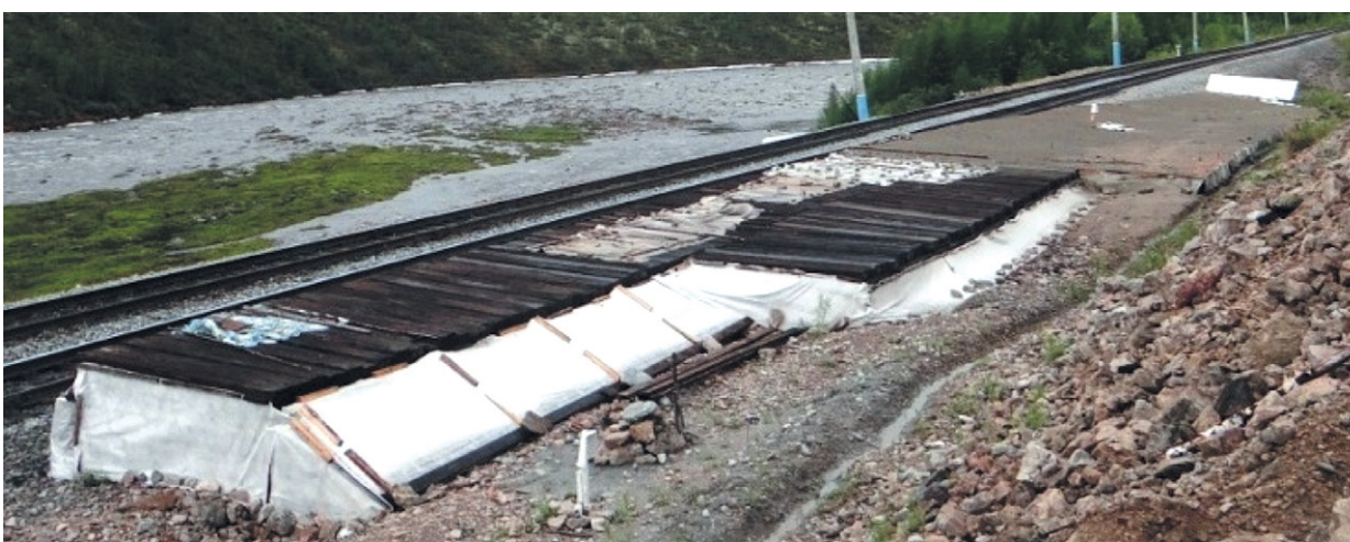
Рис. 5. Солнцезащитный навес № 1 над обочиной и кюветом слева от первого пути по ходу километров (1841 км ВСЖД, июнь 2015 г.)
