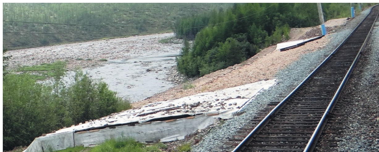
Рис. 6. Солнцезащитный навес № 2 над обочиной, откосом насыпи и бермой справа от второго пути по ходу километров (1841 км ВСЖД, июнь 2015 г.)
