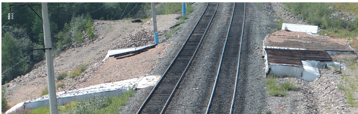
Рис. 4. Солнцезащитные навесы № 1 (справа на рис.) и № 2 (слева на рис.) на участке 1841 км ВСЖД (вид против хода километров, 5.08.2014 г.)
