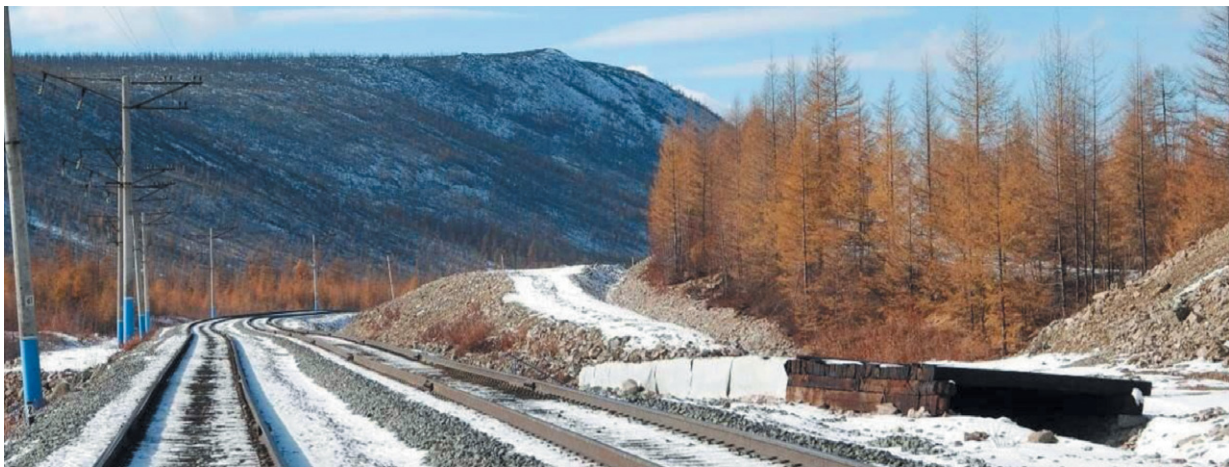
Рис. 1. Солнцезащитный навес № 1 над обочиной и кюветом на участке 1841 км ВСЖД (октябрь 2010 г.)
