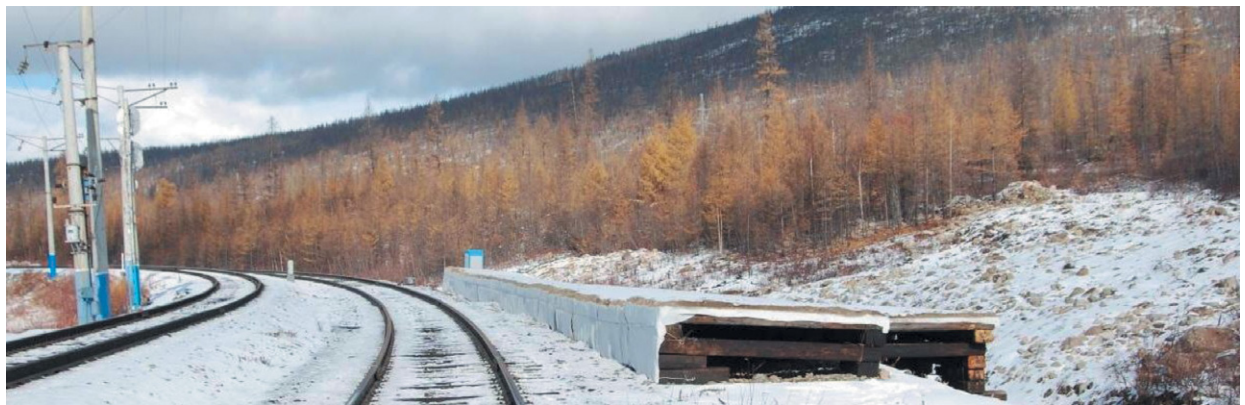
Рис. 12. Солнцеосадкозащитный навес из шпал над обочиной и откосом насыпи (1835 км ВСЖД, октябрь 2010 г.)
